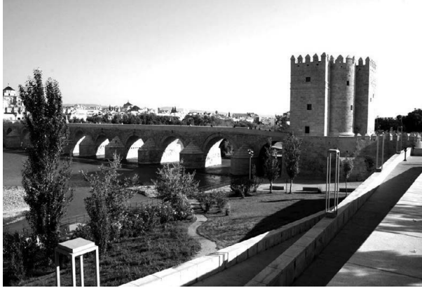
Figura 5. Intervención sobre la Torre de la Calahorra y su entorno. Fuente: A. Mulero.
