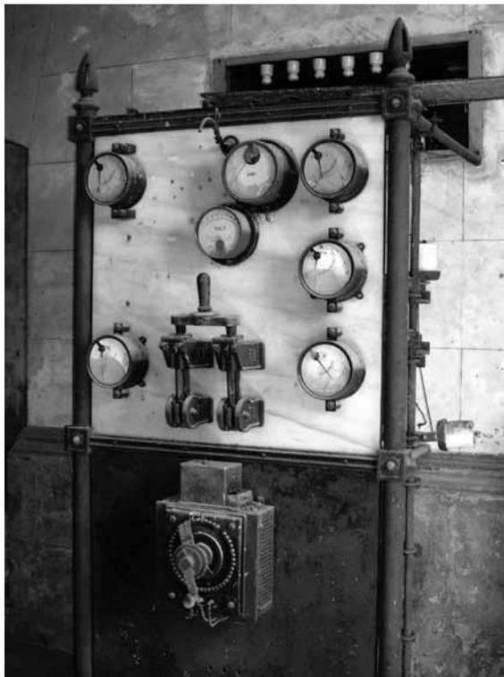
**LÁM. 8:** *Cuadro eléctrico Siemens, añadido en la reforma de la central hidroeléctrica de 1922-23.*
