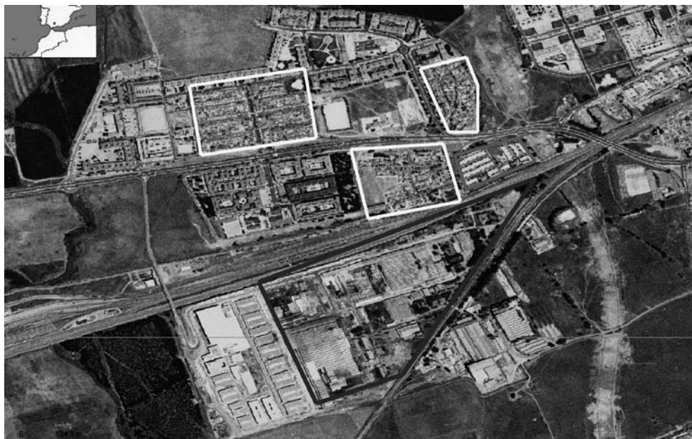
LÁM. 1: Localización, sobre fotografía aérea reciente, del conjunto fabril de SECEM (abajo) y de las tres barriadas obreras, junto a la desaparecida de empleados (zona central, a la derecha). Buena parte de las naves que se pueden ver en esta toma ya no existe (Belén Vázquez Navajas y autor).
