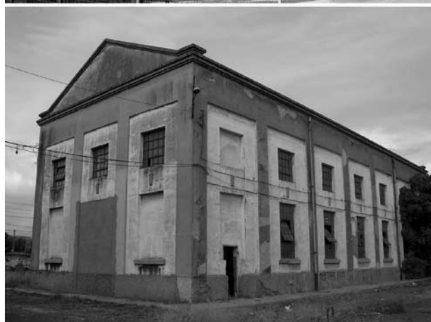
LÁM. 7: Subestación eléctrica (arriba) y Nave del generador (abajo), conocida entre los trabajadores como “el Barco”. La primera es uno de los escasos elementos conservados de la etapa analizada en este artículo; la segunda, en cambio, fue derribada –y vaciado su solar, cimientos incluidos– en los primeros meses de 2008.
