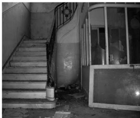
LÁM. 8: Vista parcial de la fachada de las oficinas generales, alzado planimétrico de la misma (SARMIENTO 1992, 94, fig. 9) e interior (portería), antes de que arrancasen de cuajo los mármoles de la escalera y el hierro forjado de su barandilla.
