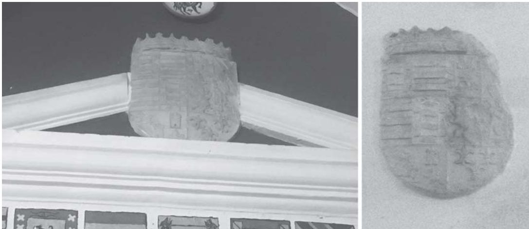
Fig. 6: Actual estado de dos de los escudos. El primero, en el frontón de la escalera principal del Mesón del Duque. El segundo, en las caballerizas del palacio ducal. Fuente: Foto propia (izquierda) y aportación de A. Berral (derecha).
