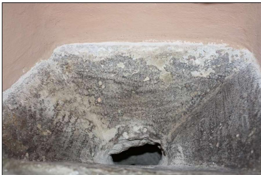
**Figura 43** - Particolare dell'imbuto di raccolta delle acque piovane (foto dell'autore)
