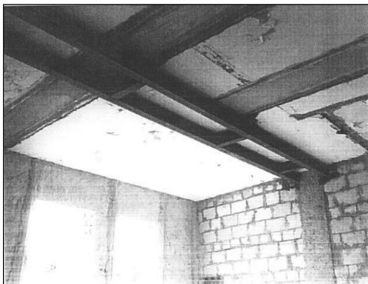
**Figura 88** – Travi in ferro di sostegno al solaio ammalorato (fonte: progetto arch. E. Giliberti)
