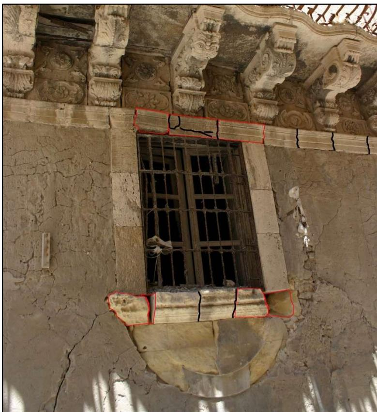
**Figura 113** – Degrado della finestra angolare sinistra con vistose lesioni e disarticolazioni della base e dell'architrave (fonte: [www.lasiciliainrete.it](http://www.lasiciliainrete.it))
