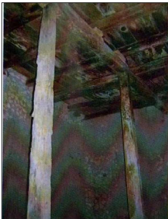
**Figura 87** – Puntelli in solaio a rischio crollo (fonte: progetto arch. E. Giliberti)
