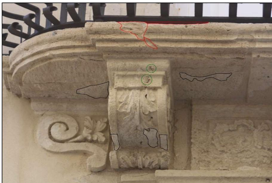
**Figura 111** – Particolare del balcone sinistro interno dopo il restauro, segni di distacco e porzioni soggette ad efflorescenze (foto dell'autore)
