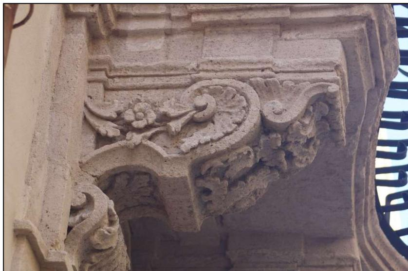
**Figura 57** - Mensola del balcone centrale ad elementi spiraliformi (foto dell'autore)
