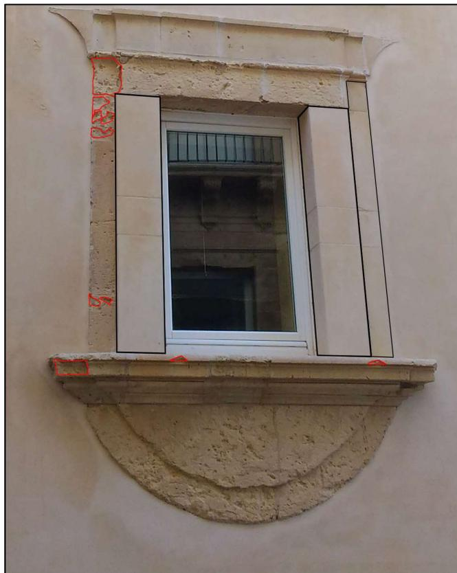
**Figura 122** – Finestra destra esterna dopo il restauro, con sostituzione degli stipiti (foto dell'autore)
