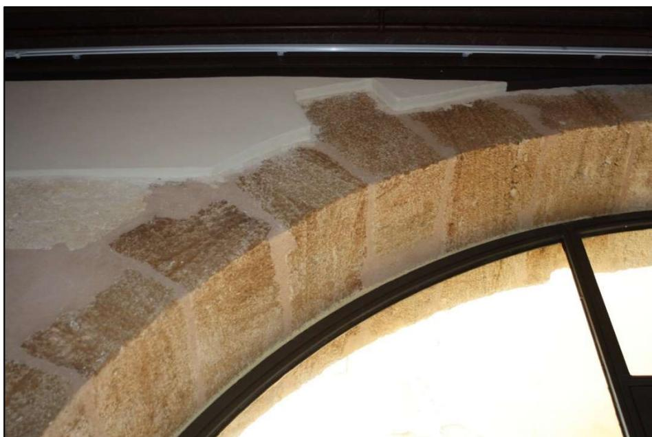
**Figura 129** – Finestra ad arco su Ronco Spiraglio dopo il restauro, con riempimenti a base di resine, polvere di marmo e terre locali. Foto dell'autore
