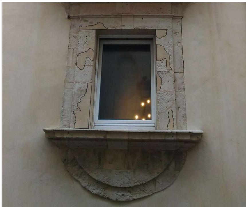
**Figura 112** – Finestra interna sinistra con interventi di riempimento di porzioni mancanti su stipiti e architrave (foto dell'autore)
