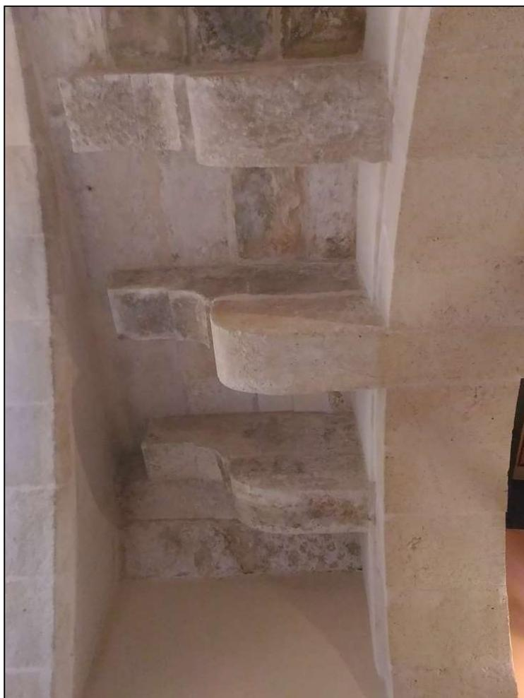
**Figura 35** – Mensole di sostegno del ballatoio del primo piano. Da notare il collegamento con l'arco di ingresso (foto dell'autore).
