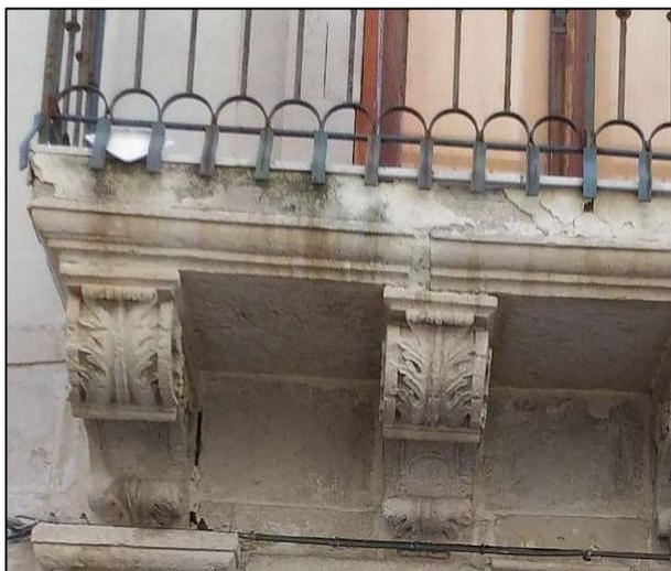
**Figura 73** – Particolare delle mensole spiraliformi del palazzo di via Vittorio Veneto. Foto dell'autore
