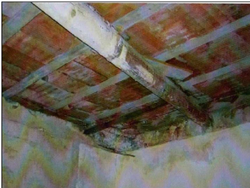
**Figura 89** - Solaio in latero-cemento realizzato negli anni '60 (fonte: progetto arch. E. Giliberti)
