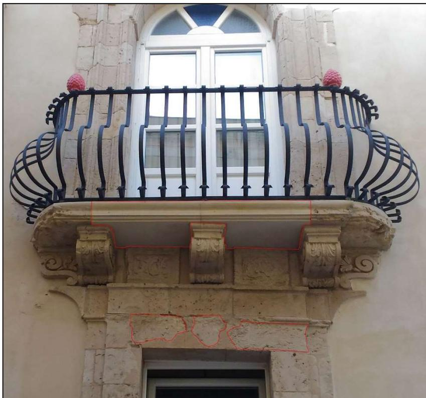
**Figura 118** – Balcone destro interno, con sostituzione degli elementi del ballatoio e fenomeni di erosione nella sottostante finestra (foto dell'autore)
