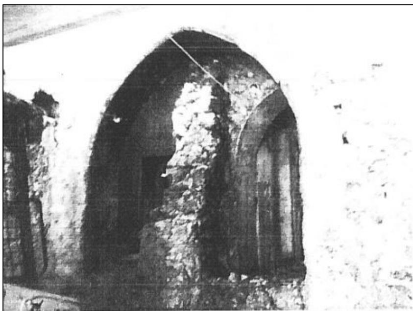
**Figura 80** - Ritrovamento di un'apertura ad arco medievale al piano terra, zona Est, durante la rimozione di preesistenti elementi in calcestruzzo (fonte: progetto dell'arch. E. Giliberti)
