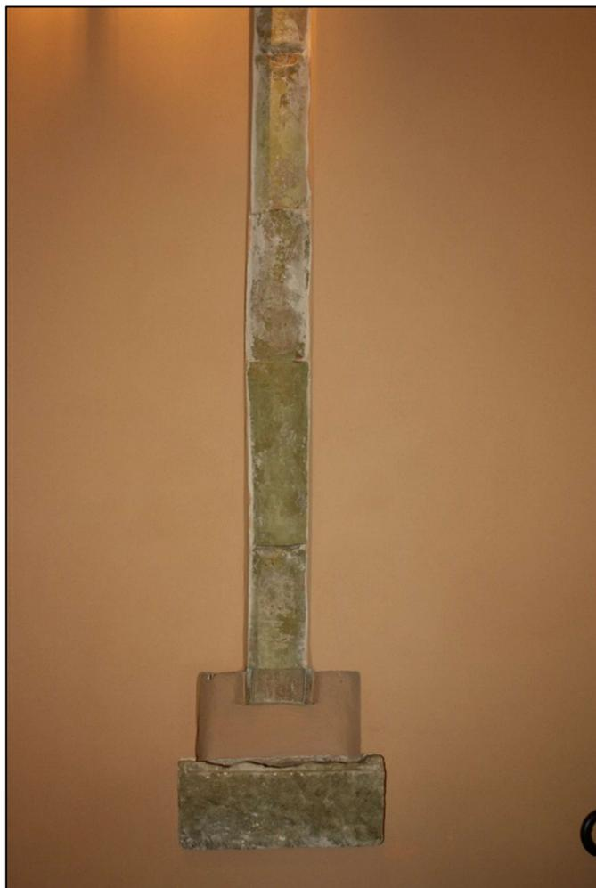
**Figura 42** - Antica canaletta di convogliamento delle acque piovane (foto dell'autore)
