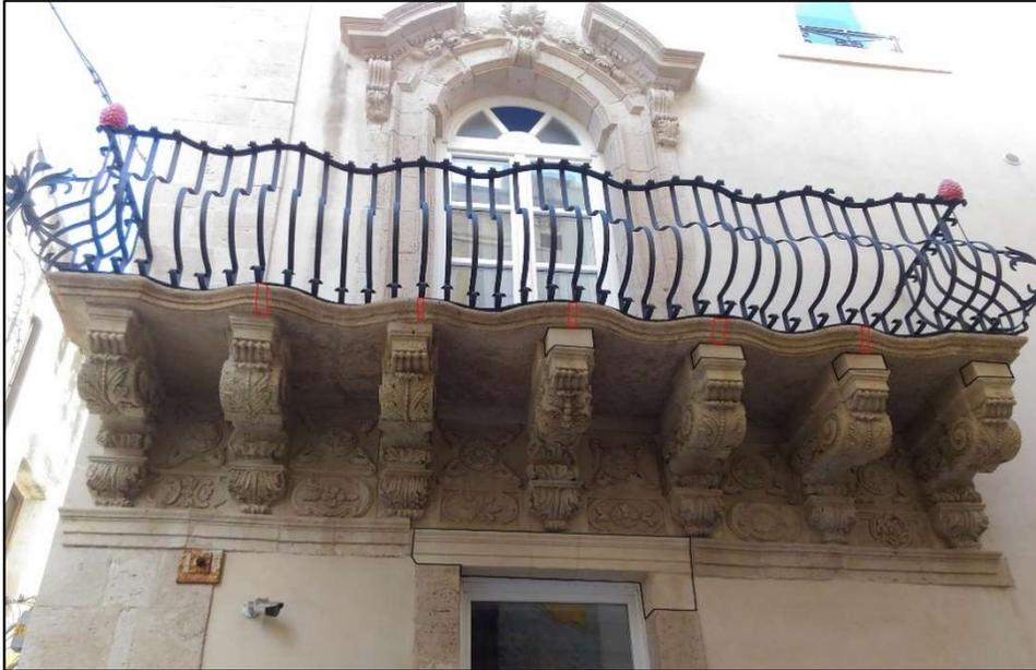
**Figura 116** - Mensole del balcone angolare sinistro dopo il restauro con sostituzione elementi e saldatura lesioni (foto dell'autore)
