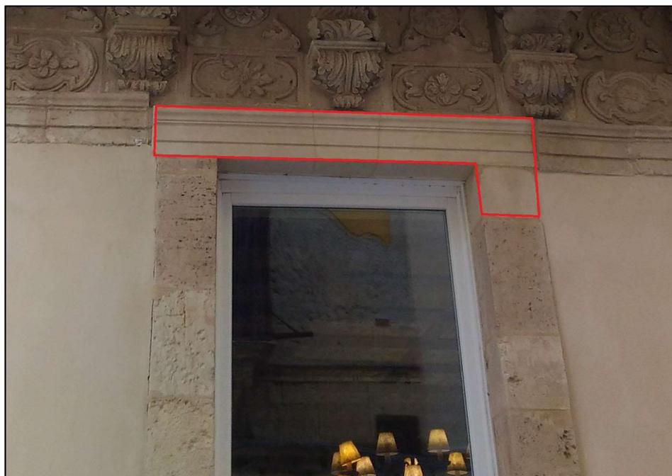
**Figura 114** – Particolare dell'architrave della finestra angolare sinistra integralmente sostituito (foto dell'autore)
