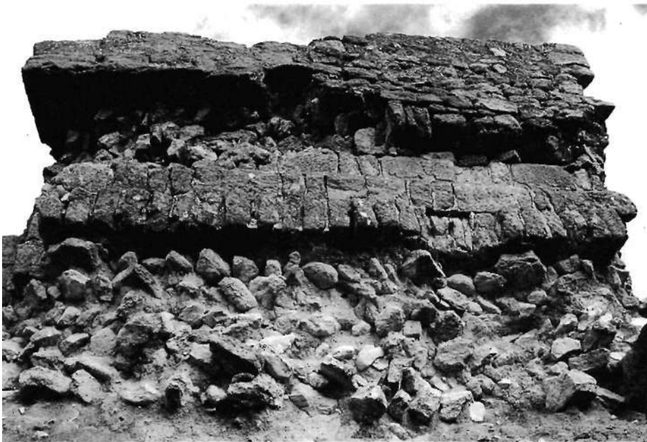
Lám. 1.- Torre de aparejo califal, perteneciente a la muralla de la villa.
