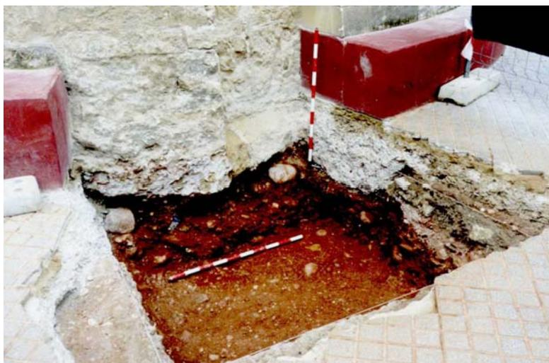
Eliminado el zuncho de hormigón, quedó al descubierto el basamento del torreón pudiéndose apreciar la cimentación de ésta. Huelga decir que la fosa contemporánea y el propio zuncho de hormigón han provocado el arrasamiento de los
