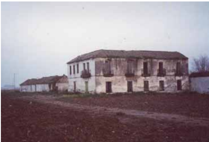
FIGURA 4 RUINAS DEL CORTIJO ABANDONADO DE EL RUBIO. CÓRDOBA
