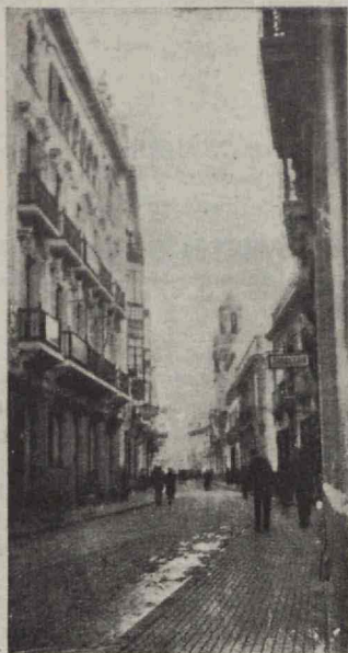
Calle Concepción, con la nueva pavimentación.
