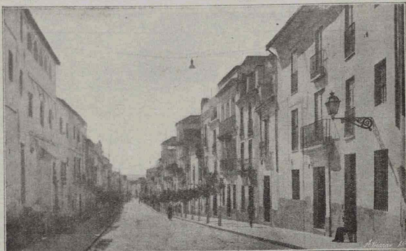
La típica calle de San Fernando, con la nueva pavimentación
