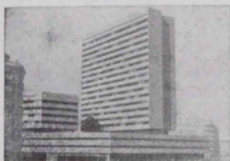
En construcción - MADRID
