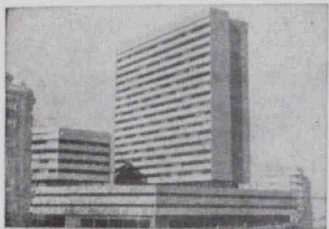
En construcción - MADRID
