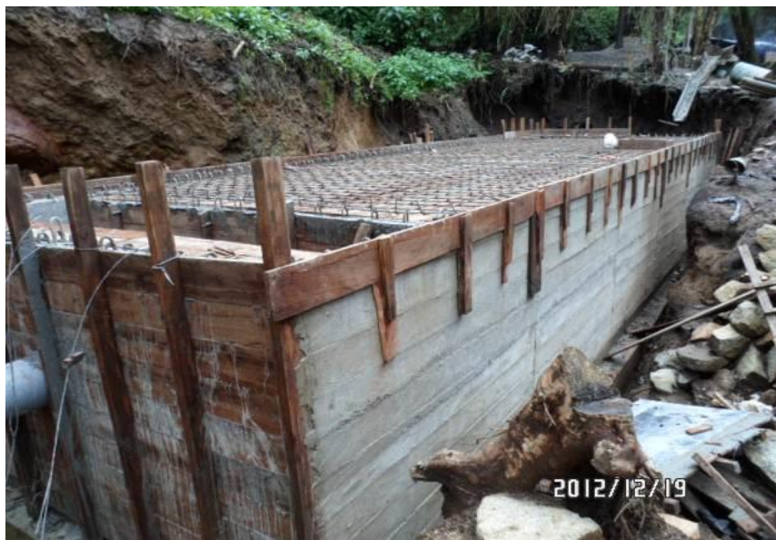
Fundición de la plancha superior del desarenador en concreto
