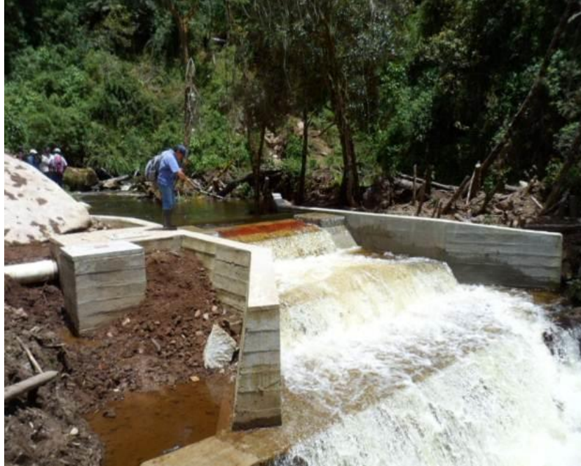
Construcción de la bocatoma
