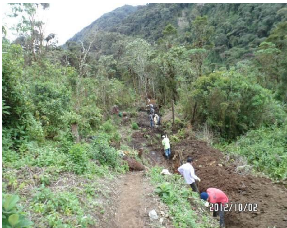
Relleno y compactación con material del sitio de la tubería instalada
