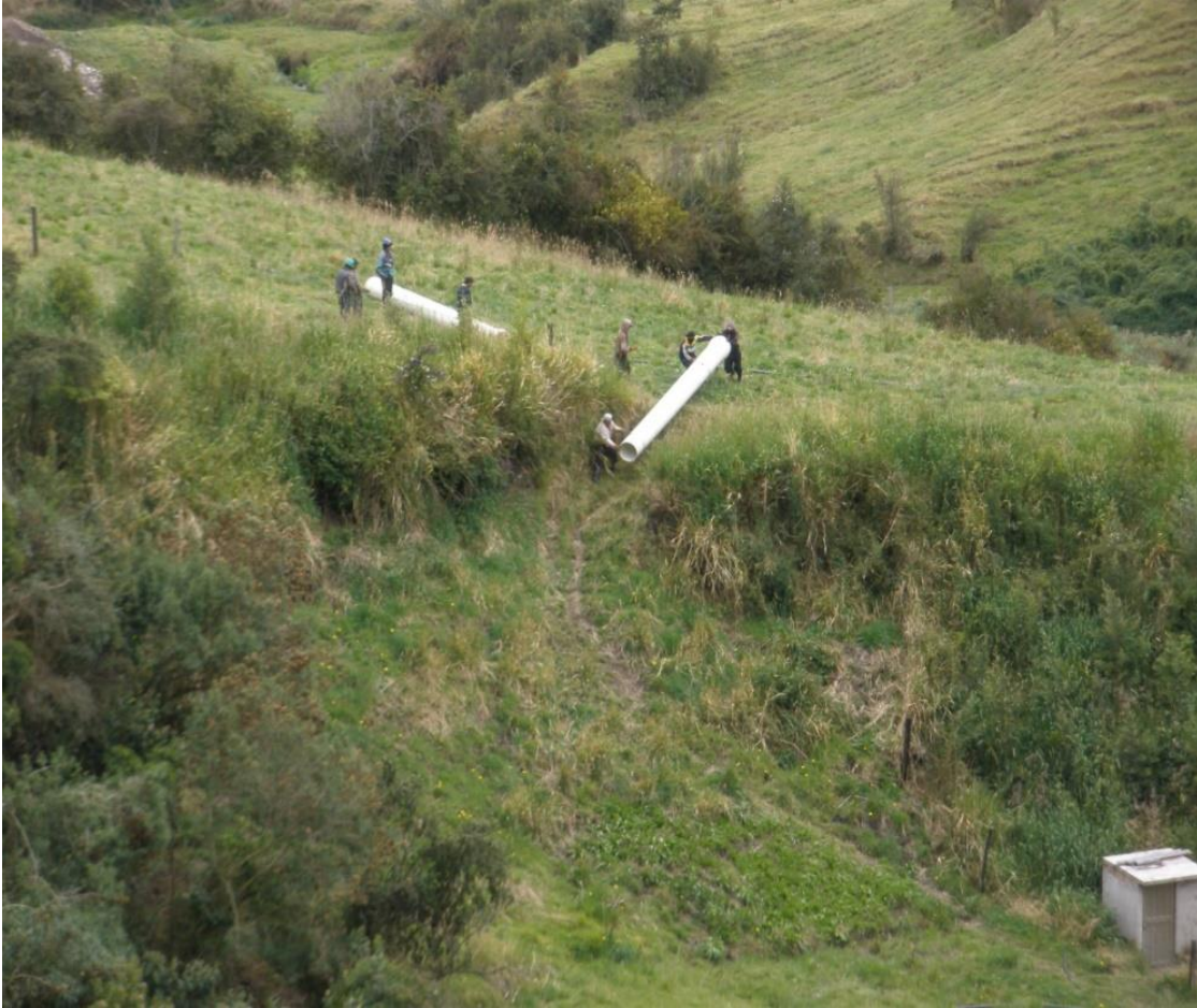
Traslado de tubería a terreno
