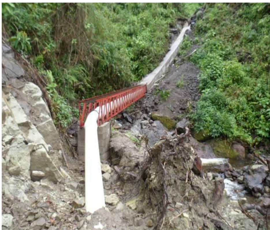
Finalización de construcción de cercha.
