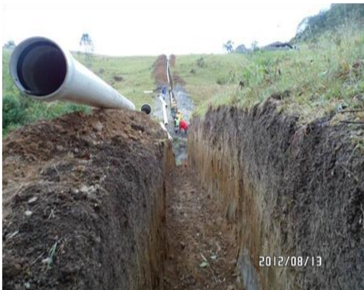
Instalación de tubos en conducción principal
