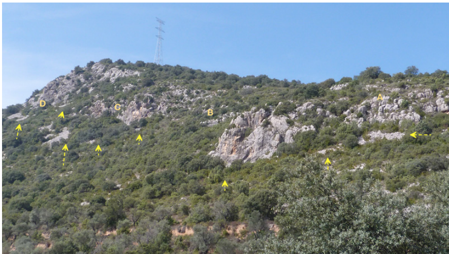
Fig. 3. Visión general de las canteras bajas de Aguinalú. El frente "B" es muy pequeño (exactamente bajo la letra). Los otros tres tienen una extensión lateral de casi un centenar de metros. También se aprecian las escombreras (flechas) (Foto: J. Gisbert).
