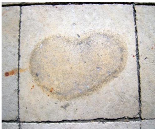
Figs. 15 e 16: Alteração cromática designada por “mancha” existente no pavimento y uma eflorescência salina existente na cúpula central da capela. Capela de São Bartolomeu, Aveiro. Fotos: NR.
