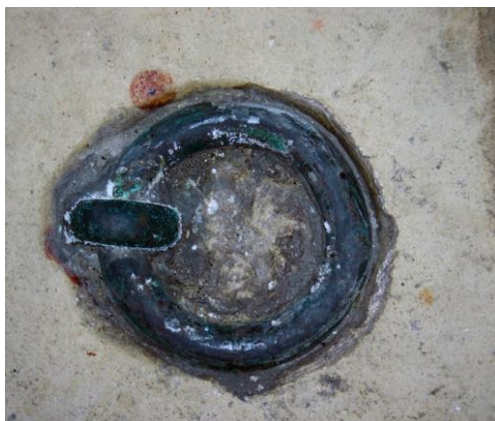
Figs. 15 e 16: Alteração cromática designada por “mancha” existente no pavimento y uma eflorescência salina existente na cúpula central da capela. Capela de São Bartolomeu, Aveiro. Fotos: NR.
