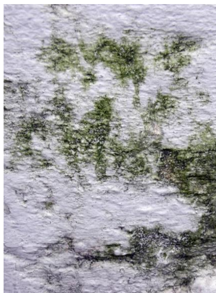
Figs. 13 e 14: Vegatação presente no pórtico y algumas algas existentes no exterior da capela. Capela São Bartolomeu, Aveiro. Fotos: NR.
