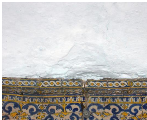
Figs. 15 e 16: Alteração cromática designada por “mancha” existente no pavimento y uma eflorescência salina existente na cúpula central da capela. Capela de São Bartolomeu, Aveiro. Fotos: NR.
