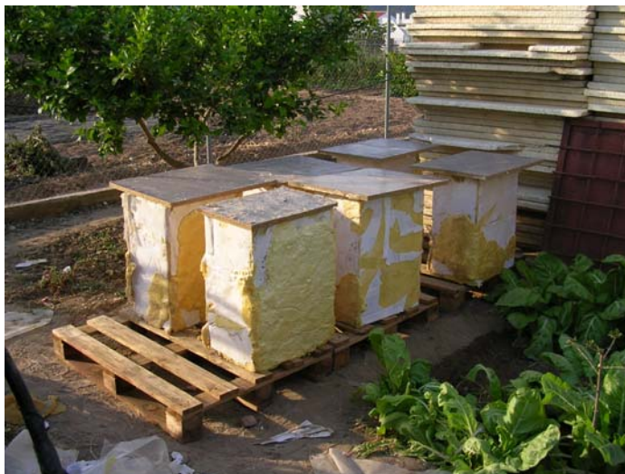
Imagen II.15. Las columnas ya reforzadas y colocada sobre palets a 0,12 m del suelo.
