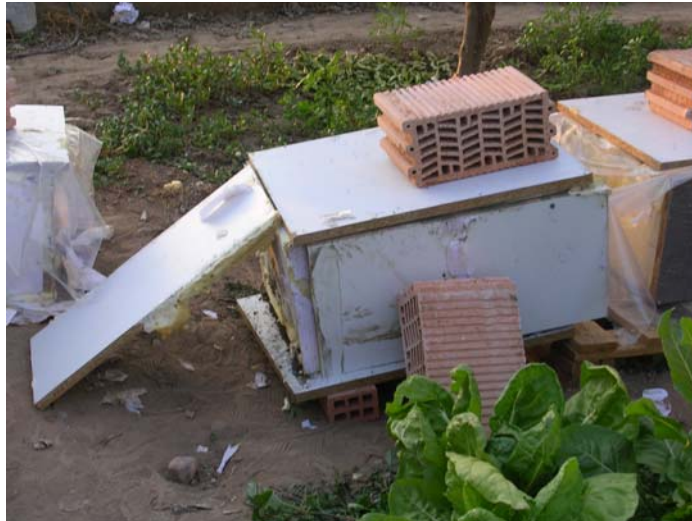
Imagen II.13. Refuerzo de la capa de poliuretano.
