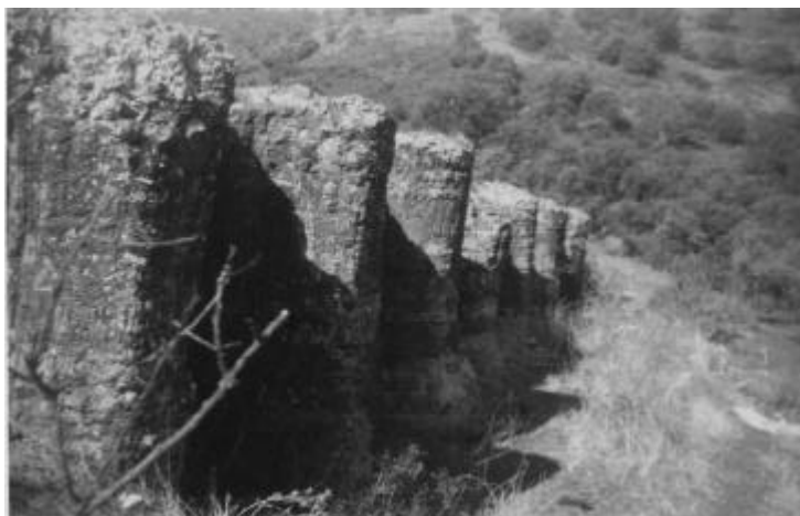
Fig. 144. Planta, alzado y foto de detalle de los contrafuertes de la cisterna del 38 Cerro del Cobre, ya derruida.
