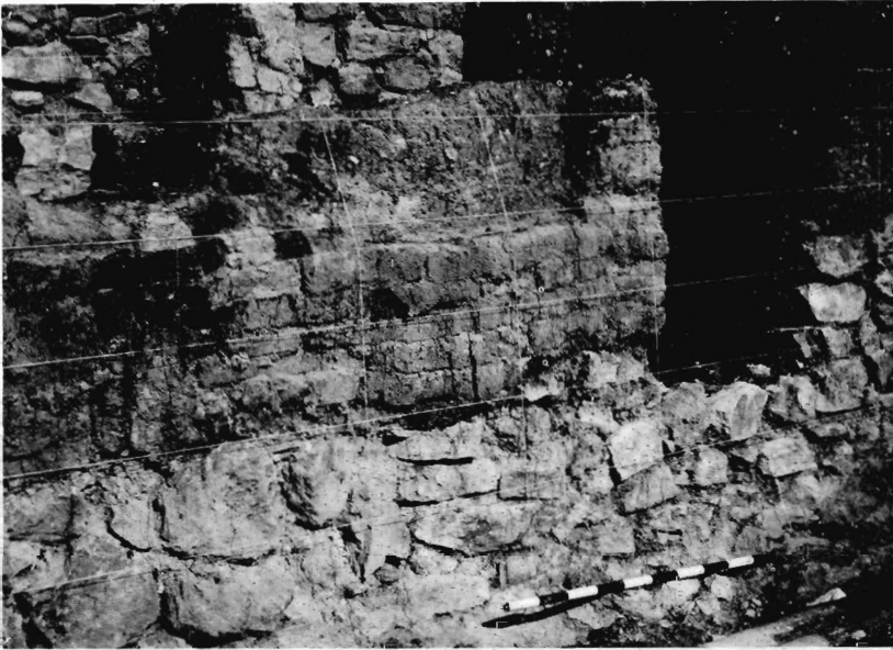
Lám. 2: Cerro de la Cruz. Sector Central. Unidad I: Alzado meridional del Muro 21, que se dispone entre las Estancias M y Q, permitiendo su comunicación a través de una puerta y una ventana. Son adobes sobre zócalo de piedras, que apoya directamente sobre la roca natural, sin zanja alguna de cimentación.
