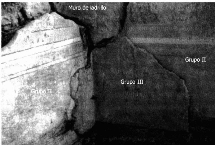
Fig. 1: Detalle de la disposición de los enfoscados II y III en la estancia 62.
