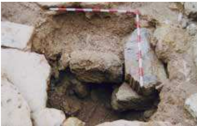
LAM. II. Obra de acceso a la cloaca. A la derecha, base de columna para sostener la cubierta.
