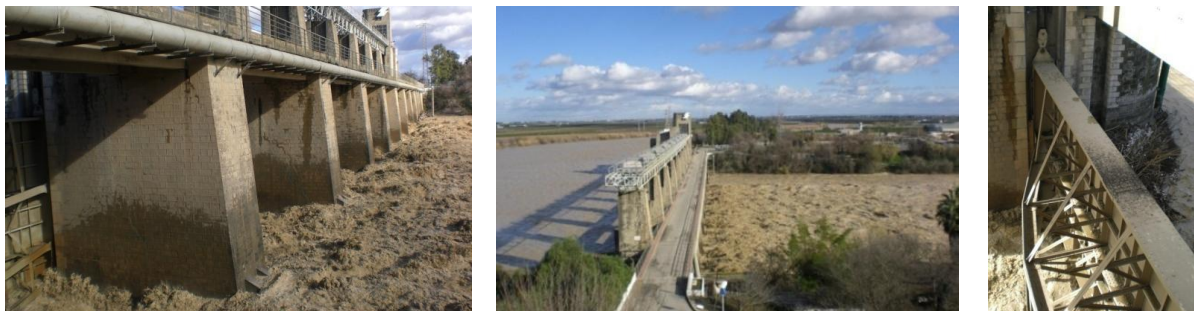
Figura F. 1 Vista de las 8 compuertas de la presa de Alcalá (a), de la lámina de agua en el embalse aguas arriba y aguas abajo de la presa (b) y detalle de una de ellas (c) (14/01/10).
